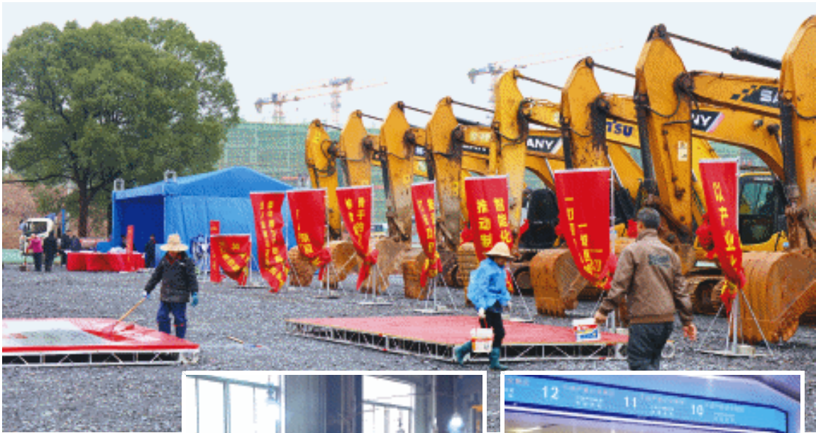
↑在长沙临空产业孵化平台一期正门对面，中欧国际智能制造产业园项目的工人们正在为正式开工做最后筹备。
